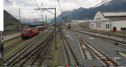
Gleisbau – Phase A
