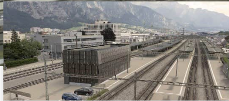
Gleisbau – Phase B
